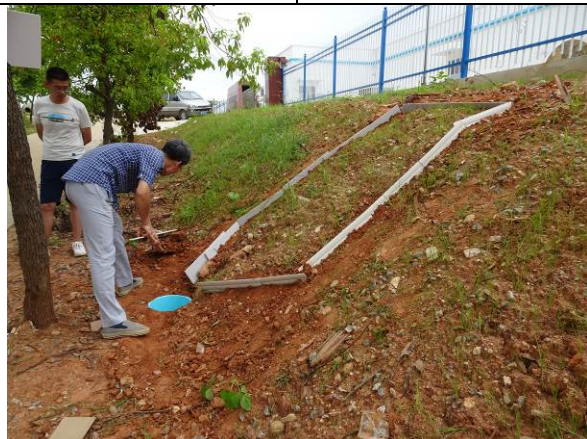
情况说明 固定监测点 拍摄时间 2017年7月
