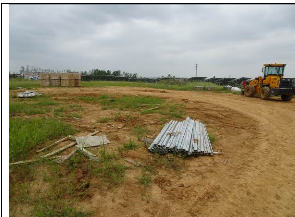
情况说明 施工场地区 拍摄时间 2017年7月
